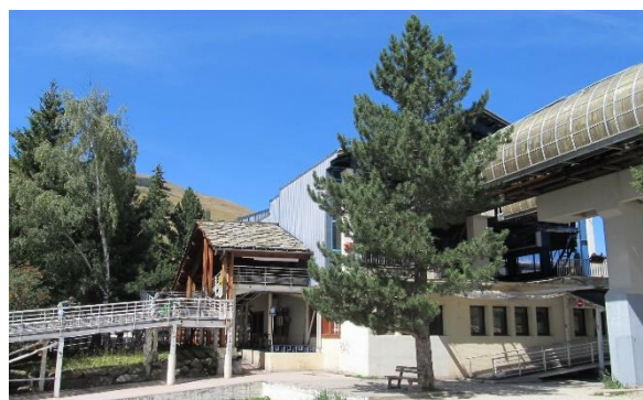
escalier d'accès depuis l'attente
