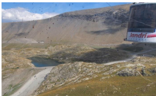
le lac de stockage d'eau potable
